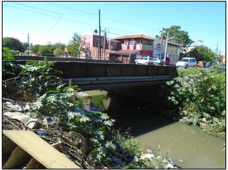
Puente existente sobre A°San Francisco
