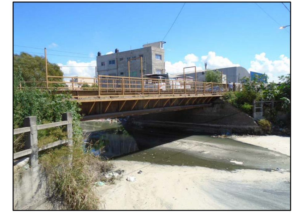
Puente existente sobre A° Las Piedras
