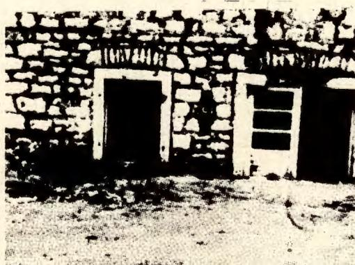
Fig. 18.- Licuefacción durante el terremoto de Montenegro (Yugoslavia); 14-IV, 1979. a) Perfil geotécnico típico obtenido después de ocurrir el sismo. b) Hundimiento de una estructura por fallo del terreno (TALAGANOV, MIHAILOV y BOGOEVSKI, 1980).
