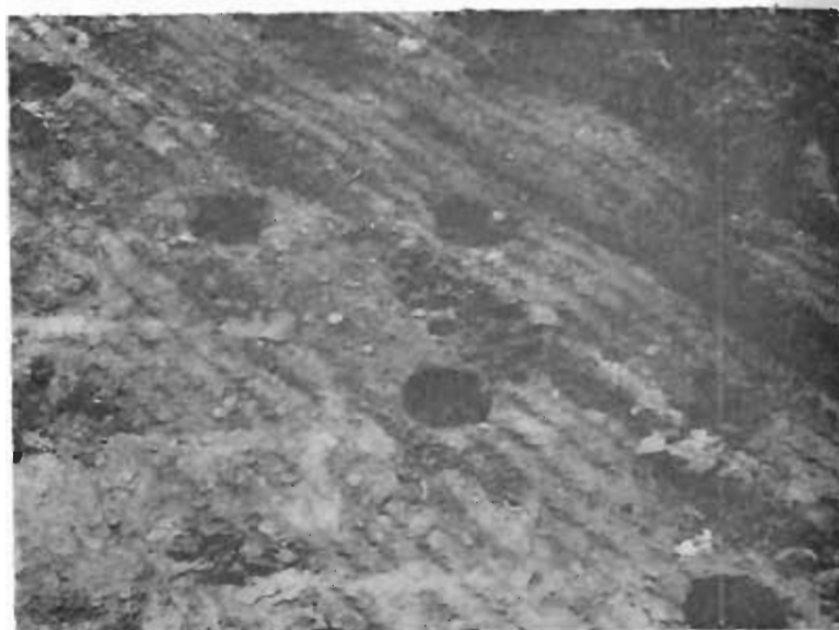
Fotografía 8 — Detalle de superficie al final de compactación con pata de cabra.
