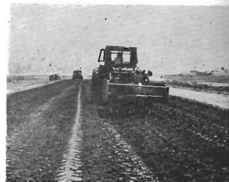
Fotografía 7 — Compactación final con equipo pata de cabra dinámico.
