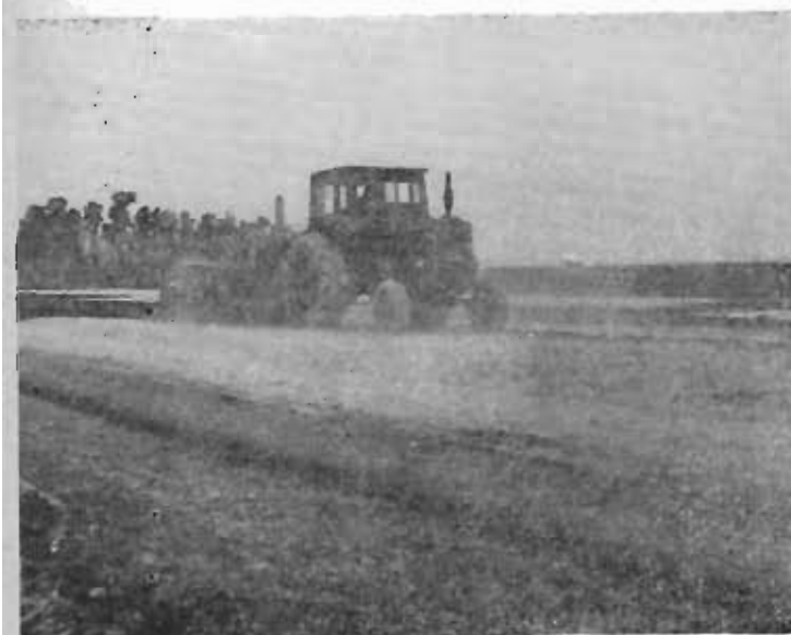
Fotografía 5 — Mezclado seco de suelo de subrasante y cal.
