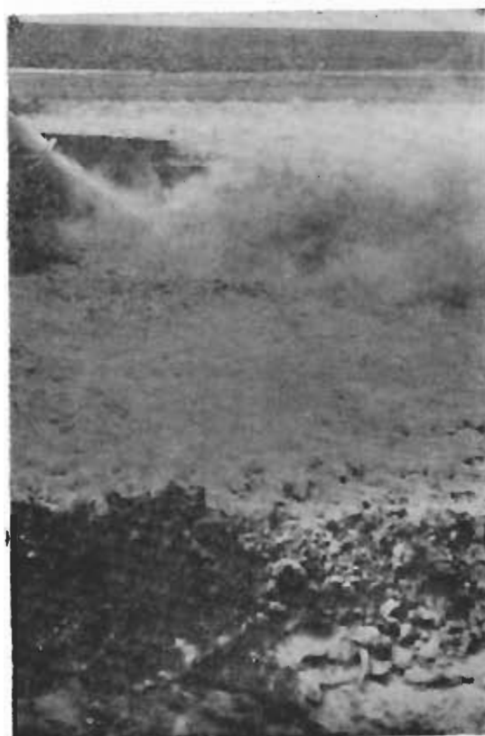
Fotografía 4 — Detalle de distribución de cal.
