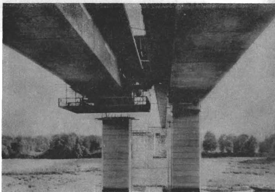
Figura 27 — Vista inferior del puente Bendorf; cimbra en voladizo pasando sobre un pilar.
