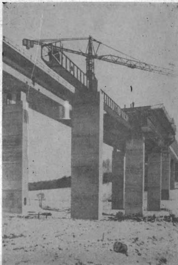
Figura 41 — Puente Pleichach en la autovía Fulda-Wurzburg durante la construcción.
