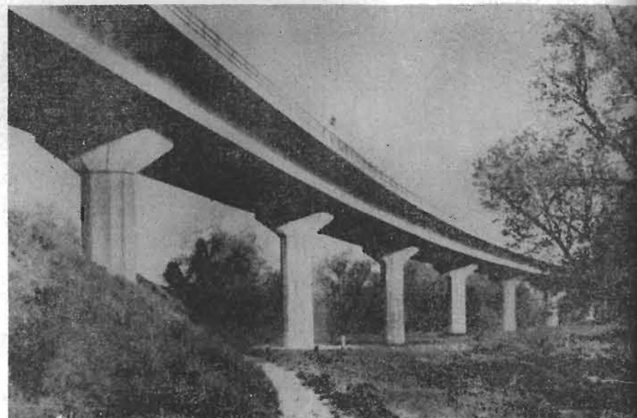
Figura 57 — Puente Namedy en la ruta federal 9; vista parcial del puente terminado.
