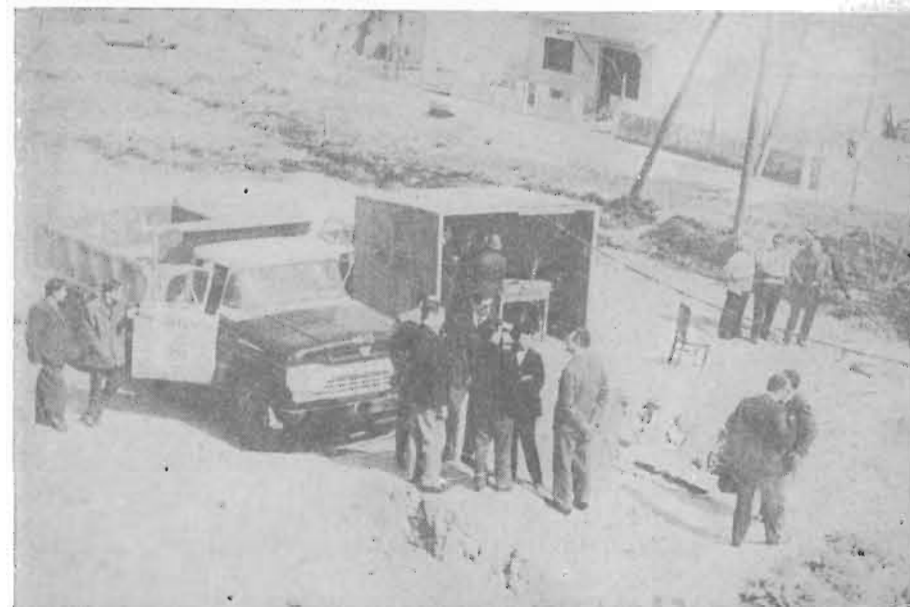
Fotografía G — Casilla de comando con el equipo central de lectura de los aparatos electroacústicos (tipo Maihak).
