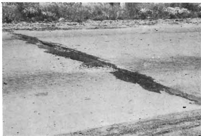
Fotografía 8. — Junta de dilatación (progresiva 2.400 m).
