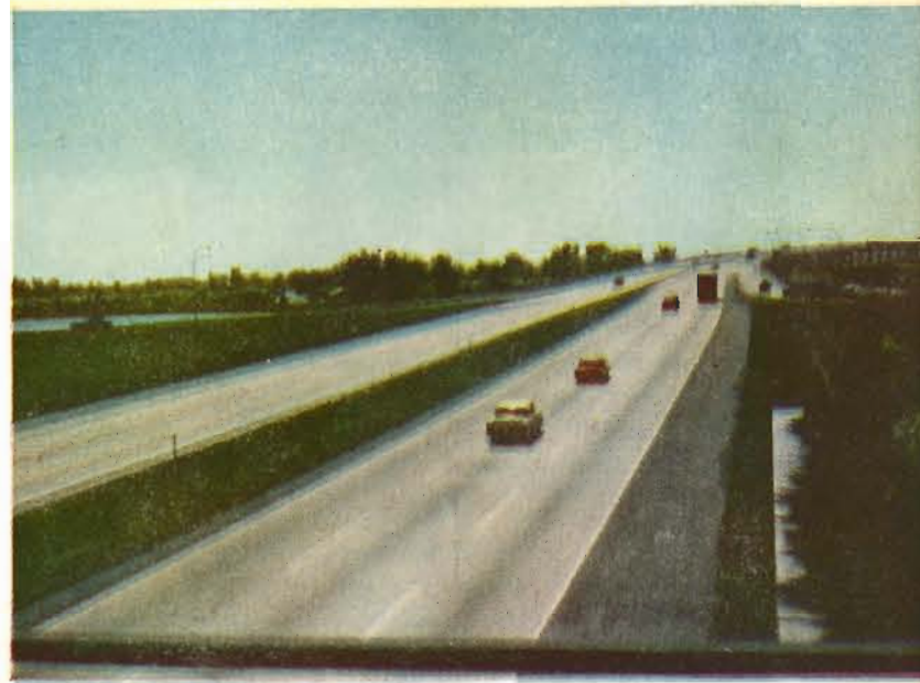
Figura 2 — Vista del Tollway, Chicago.
