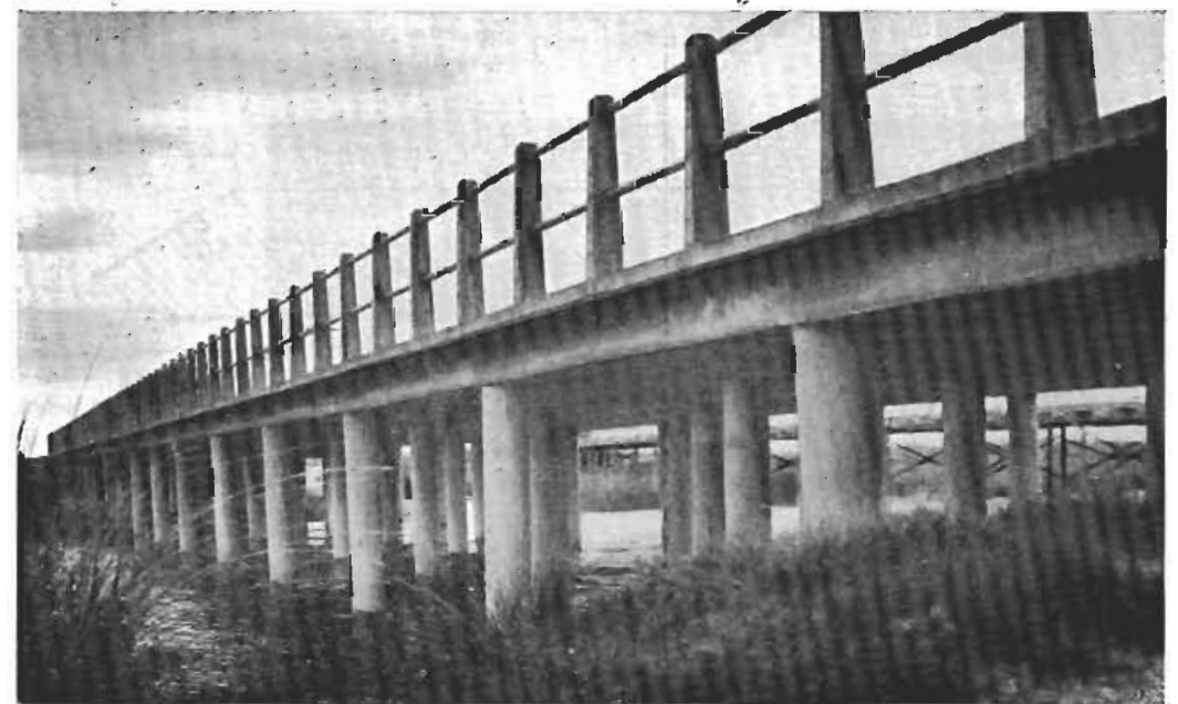
Fotografía 3 - Aspecto de la obra terminada. Puente sobre el río Samborombón, en el Camino de la Costa. (Ruta Nº 11).
