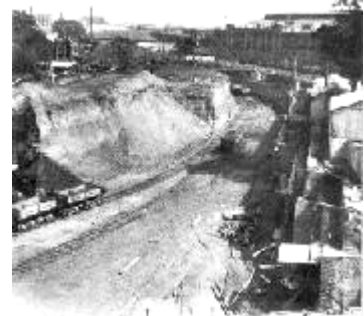
Construcción Estación Once
