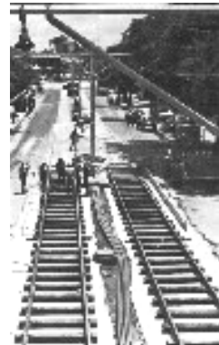
Tendido de vías del Premetro
