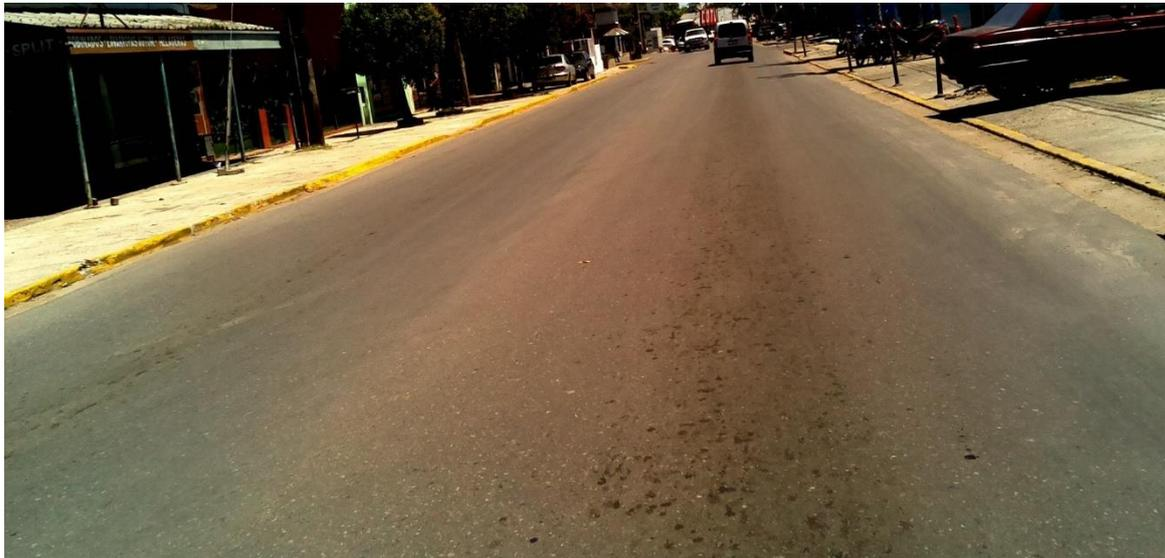
*Sector con Calzada de 7,53m de ancho y Banquinas Pavimentadas. Pr 0+000 a Pr 0+370 y Pr 1+340 a Pr. 21+730*
