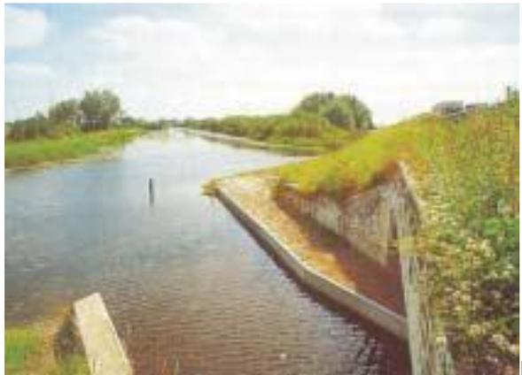
**Figura 64 - Rampa que facilita una óptima la conexión de los taludes con las plataformas secas del drenaje**
